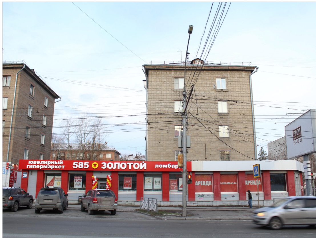
Главный фасад В-А, выходящий на проспект Карла Маркса
